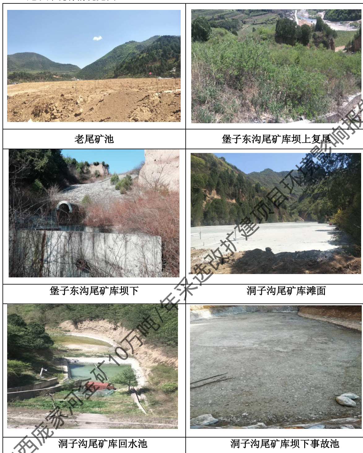
图 2.3-9 尾矿库现状照片
